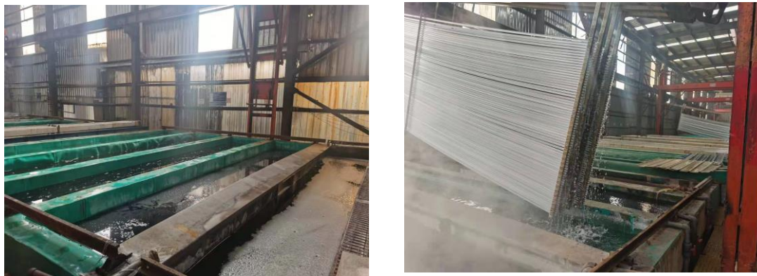
图 1-6 厂区现有阳极氧化生产线图
