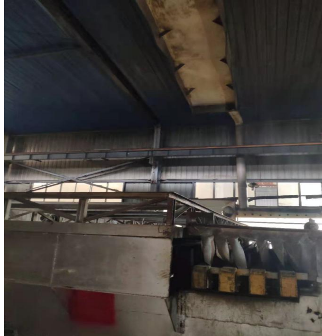
图 1-7 厂区现有电泳有机废气收集、处理设施图
